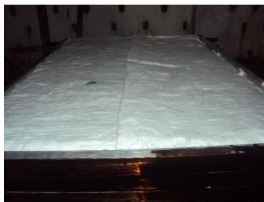
(d) Fixing of insulation
